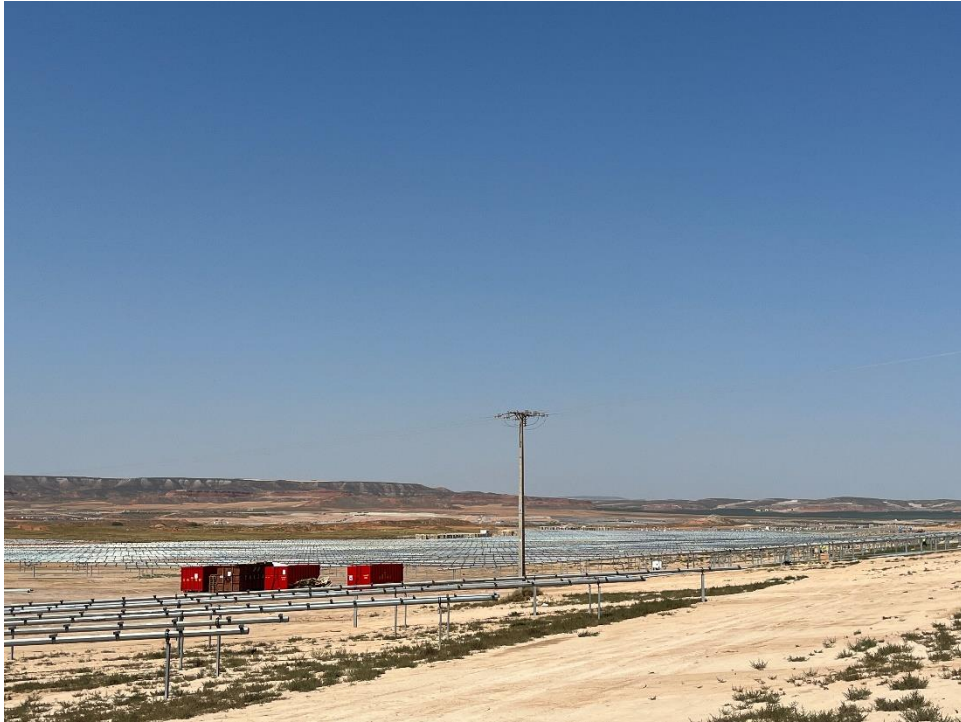
Figura 8 Vista general de la planta
