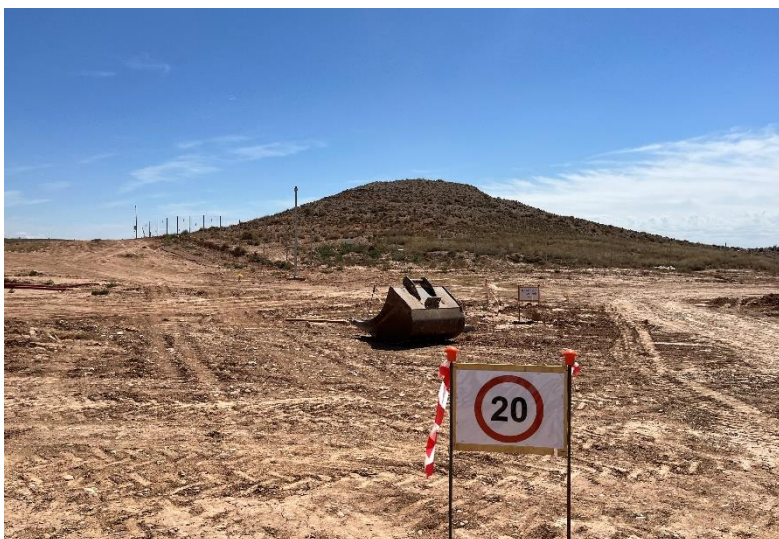
Figura 5 Señalización en obra
