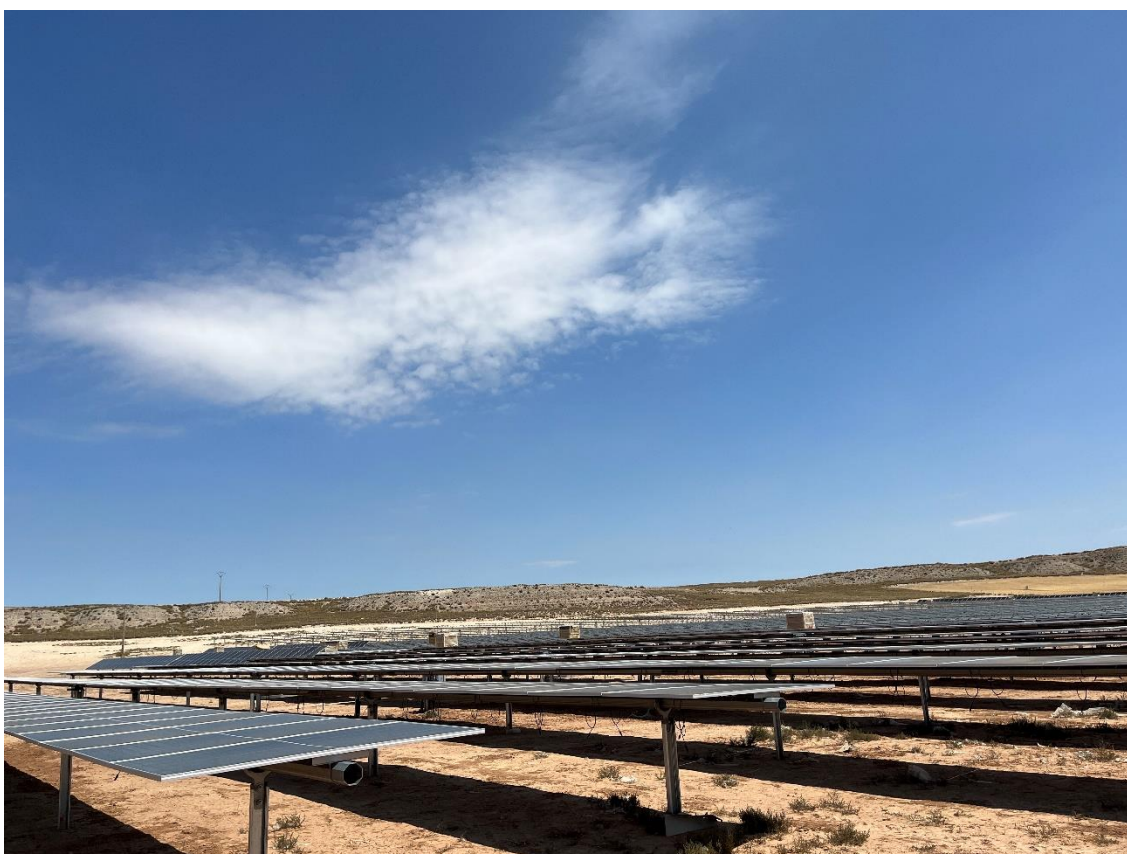
Figura 2 Montaje de los módulos fotovoltaicos
