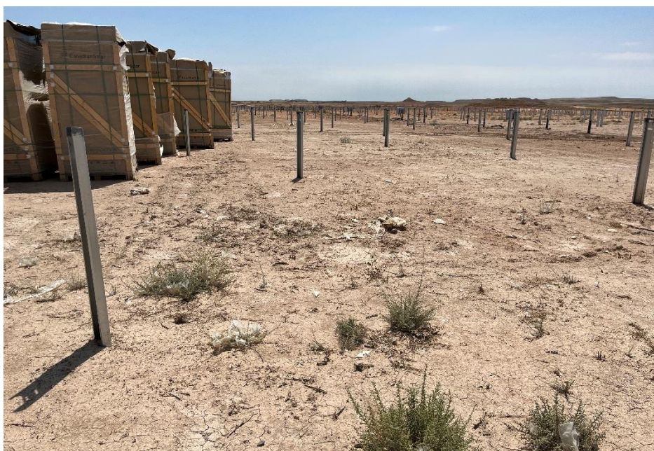
Figura 4 Zona de acopio de módulos
